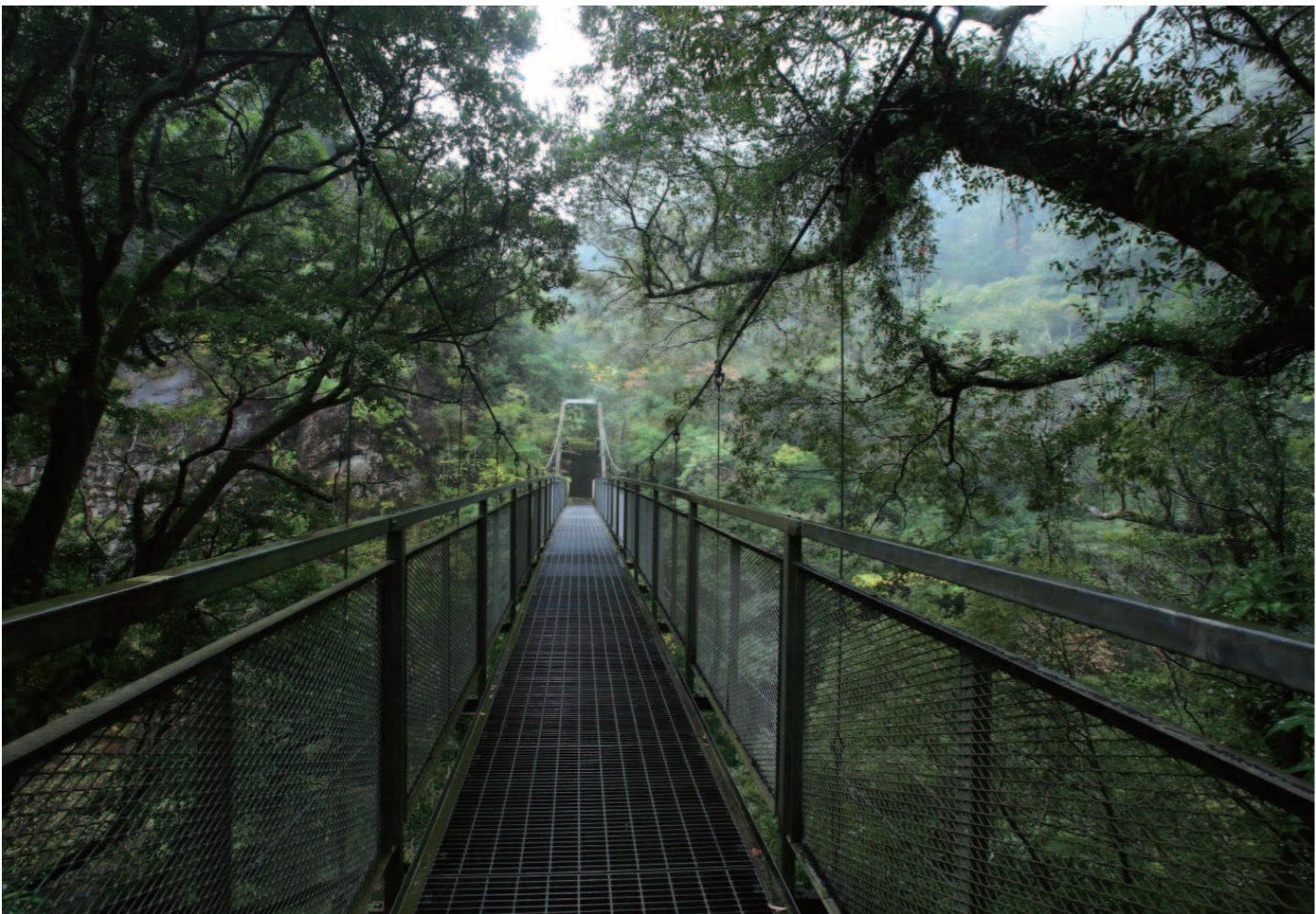
遊歩道に架かる7本の橋。橋も風景の一部となり、それぞれが趣のある佇まいを見せている。
